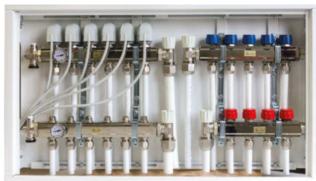
particolare del collettore di distribuzione
